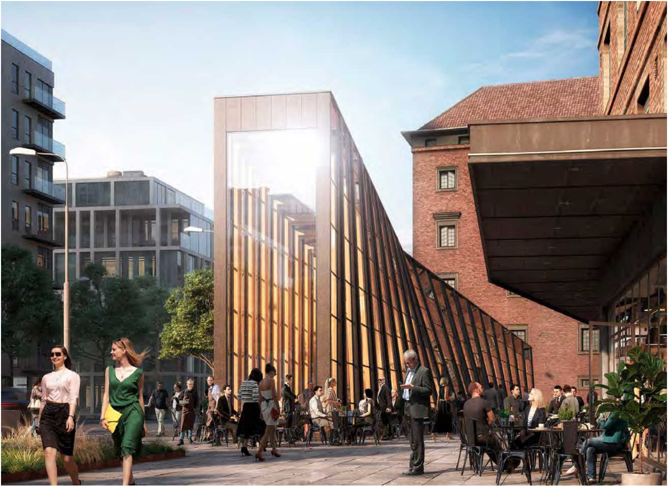
Kvarteret Mitokondrien är en del av satsningen som fått namnet Norra Station. Denna nya paviljong kommer att husera en restaurang.
