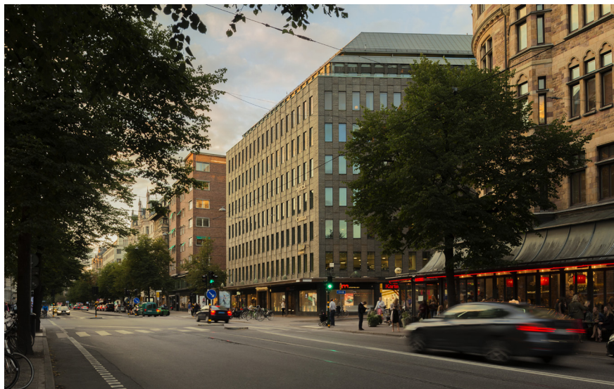
Fastigheten Skrävelberget Större 20, Birger Jarlgatan 6. Foto: Jonas Malmström
